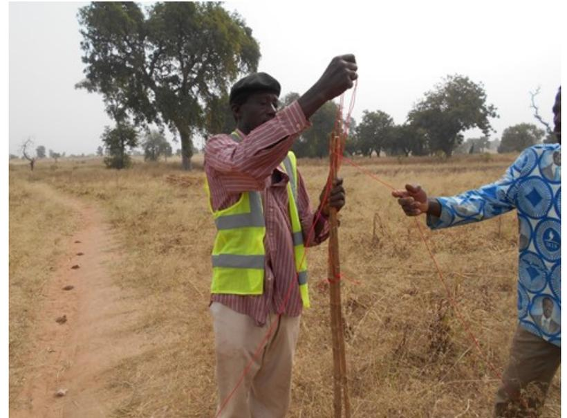
*Ici une Technique simple de piquetage à l'aide d'un cordeau gradué et marqué à l'aide des ficelles.*
